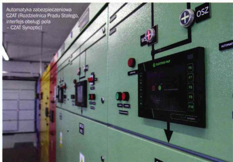
Automatyka zabezpieczeniowa CZAT 6 (Rozdzielnica Prądu Stałego, automatyka pola wyłącznika rezerwowego)
