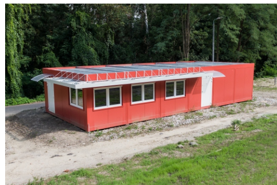
Kontener pełniący funkcję LCS składający się z pomieszczeniem Dyżurnego Ruchu oraz wydzielonej części z automatyką
