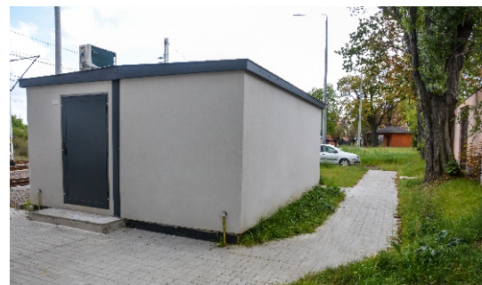
Kontener systemu UPK-PAT-CZAT3000plus, stacja Świebodzice
