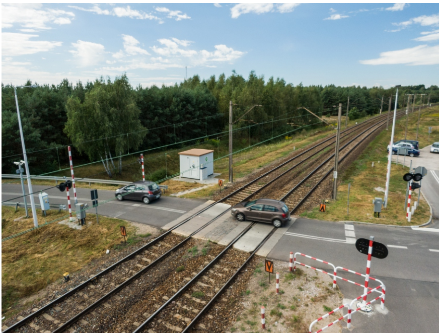
Przejazd kolejowo-drogowy kat. B wraz z kontenerem systemu PERUN
