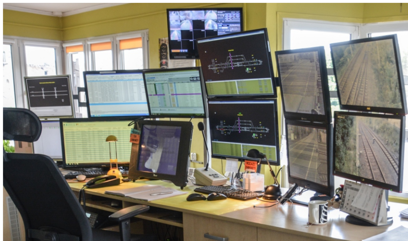
Stanowisko Dyżurnego Ruchu wyposażone w komputerowy pulpit zobrazowania systemu UPK-PAT-CZAT3000plus
