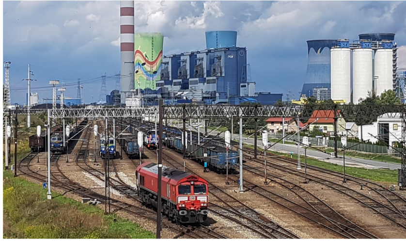
Bocznicą kolejową przy Elektrowni Opole obsługiwana przez system BUSZ-SRK-CZAT3000plus
