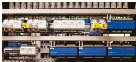
Wnętrze kontenera z zabudowanymi stojakami automatyki i przełącznikami
