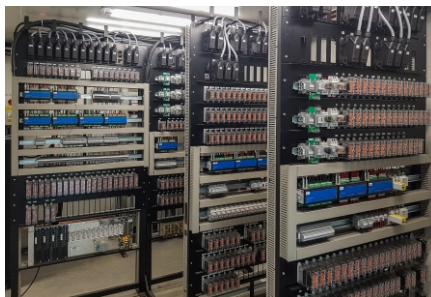
Kontener systemu UPK-PAT-CZAT3000plus, stacja Wałbrzych Miasto
