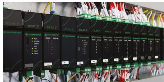
Zestaw modułów CZAT7 odpowiedzialny w systemie PERUN za realizację funkcji logicznych i działanie warstwy wykonawczej
